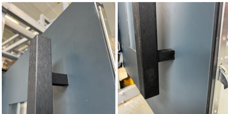
Fot. 29, 30 Mocowanie pochwytu po stronie zewnętrznej skrzydła.
