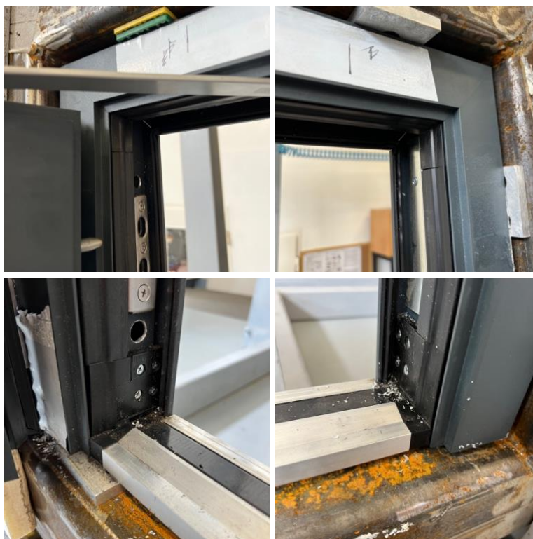
Fot. 21, 22, 23, 24 Połączenia kształtowników głównych oraz osadzenie uszczelki przylgowych.
