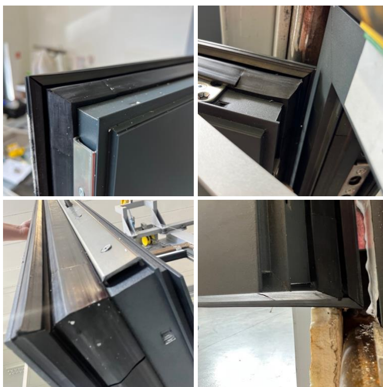
Fot. 25, 26, 27, 28 Naroża skrzydła oraz osadzenie uszczelki przylgowych.
