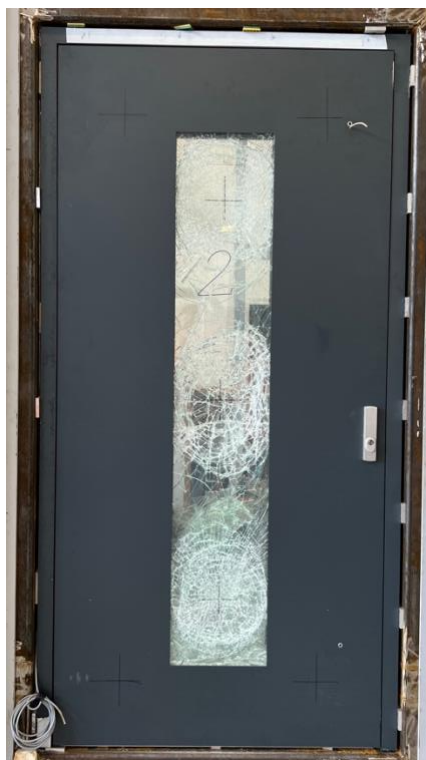
Badanie odporności na obciążenie dynamiczne. Widoczne uszkodzenia po badaniu.
