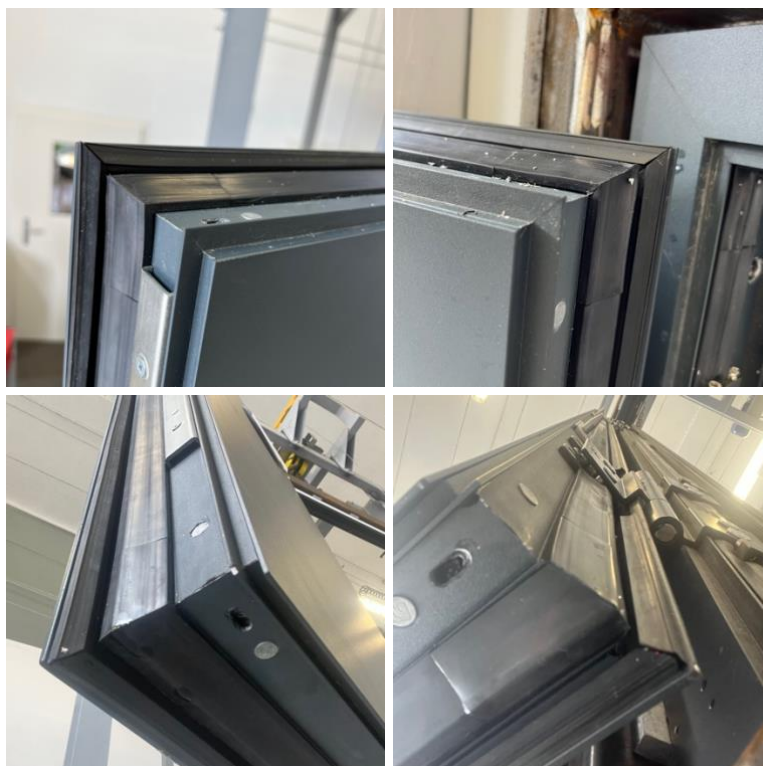
Fot. 28-31 Naroża skrzydła oraz osadzenie uszczelek przylgowych.
