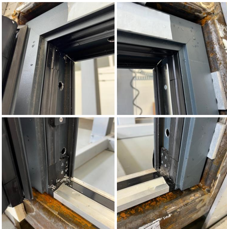
Fot. 24-27 Połączenia kształtowników głównych oraz osadzenie uszczelek przylgowych.
