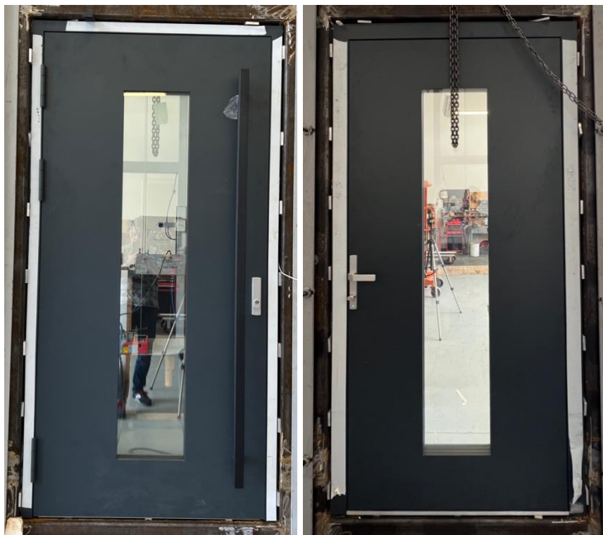
Fot. 32, 33 Widok ogólny obiektu badań Nr 2 z skrzydłem przeszklonym oraz zewnętrznym pochwytym od strony atakowanej i nieatakowanej.
