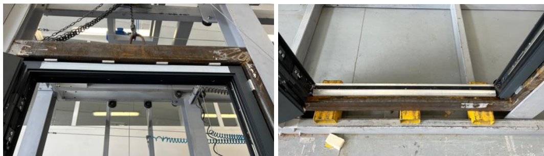
Fot. 6,7 Widok ogólny obiektu badań – otwarte skrzydło.
